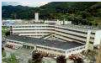
Hospital Valle del Nalón
